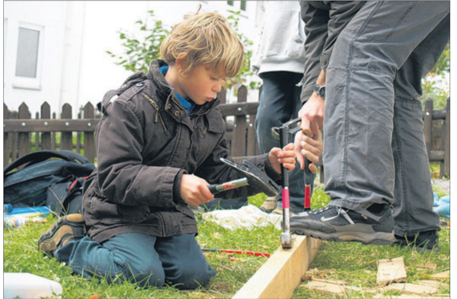
Rund ein Viertel des Umbaus erledigen die Eltern – mit Hilfe des Nachwuchses.
